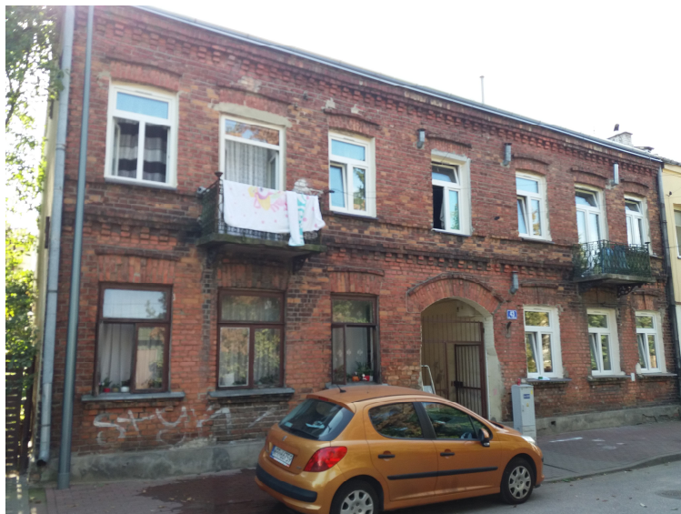
Zdjęcie nr 1: Widok elewacji frontowej
